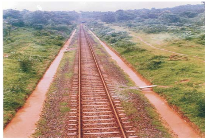
पानी के प्रभावी बहाव के लिए रेलवे ट्रैक के किनारे पक्की नालियों का निर्माण
